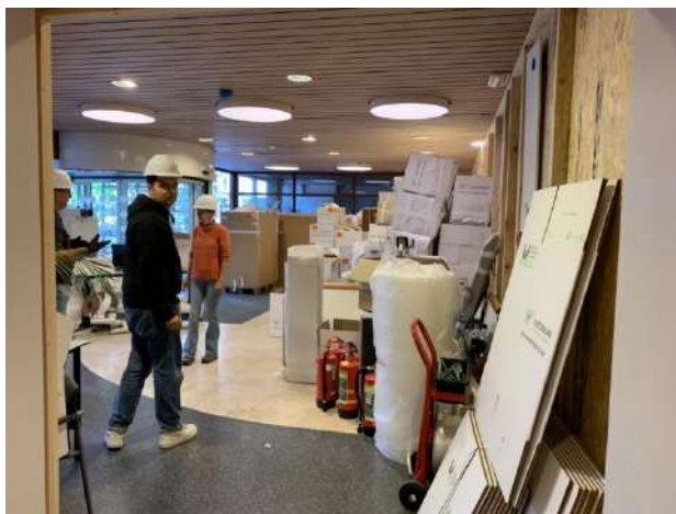
Verzamelen gedemonteerde materialen
