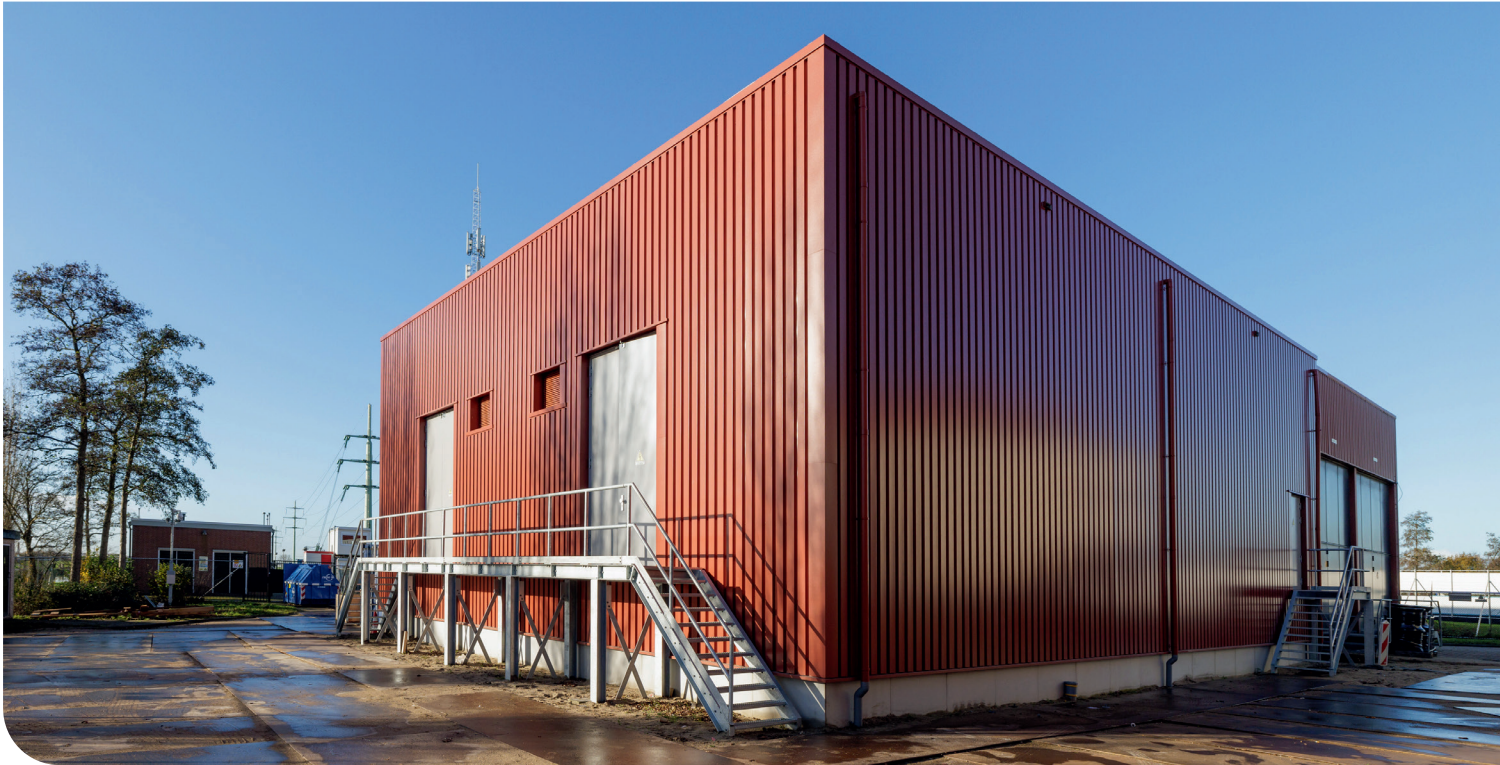
Renovatie en nieuwbouw hoogspanningsstation in Arkel Opdrachtgever: Stedin Netbeheer BV
